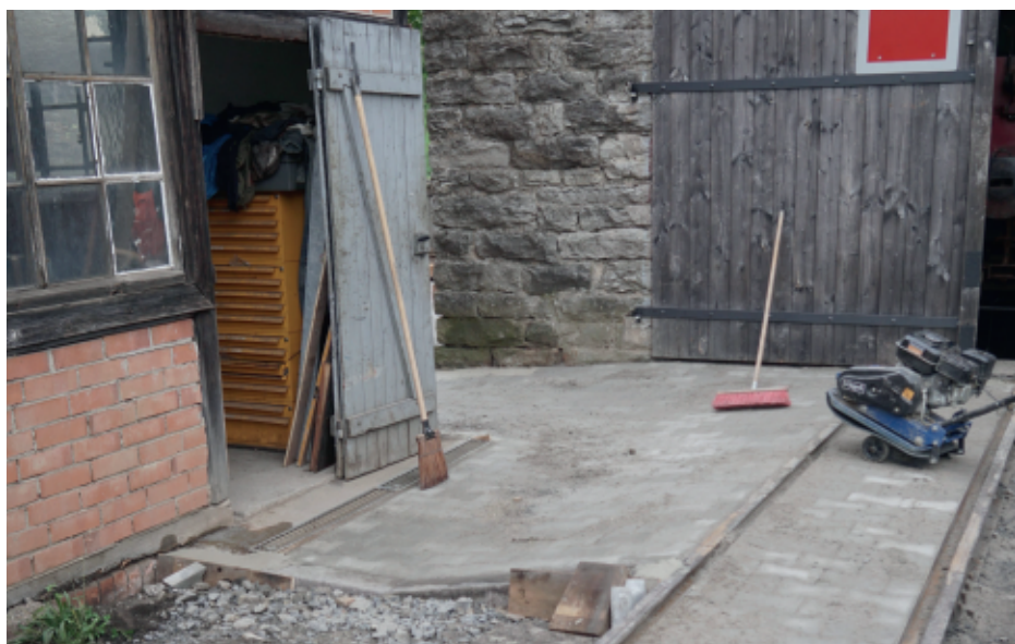
▲ Die Pflasterfläche entsteht. Bild: Stefan Haag
