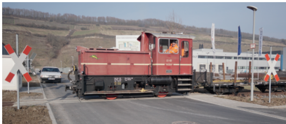
▲ Der Bahnübergang ist fertiggestellt. Bild: Stefan Haag
