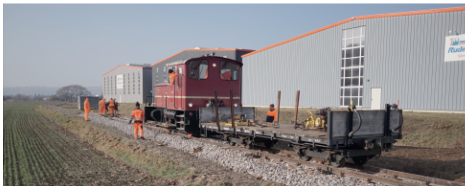
▲ Gleisbau am Streckenende. Bild: Stefan Haag
