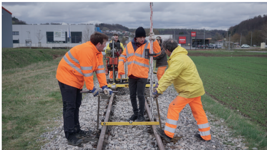
▲ Das Gleis wird rechts angehoben, bis die absolute Höhe stimmt. Danach wird links gehoben, bis das Gleis waagrecht liegt. Bild: Stefan Haag
