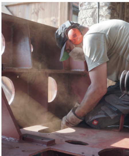
▲ Ein Hohlraum wird entrostet. Bild: Stefan Haag.
