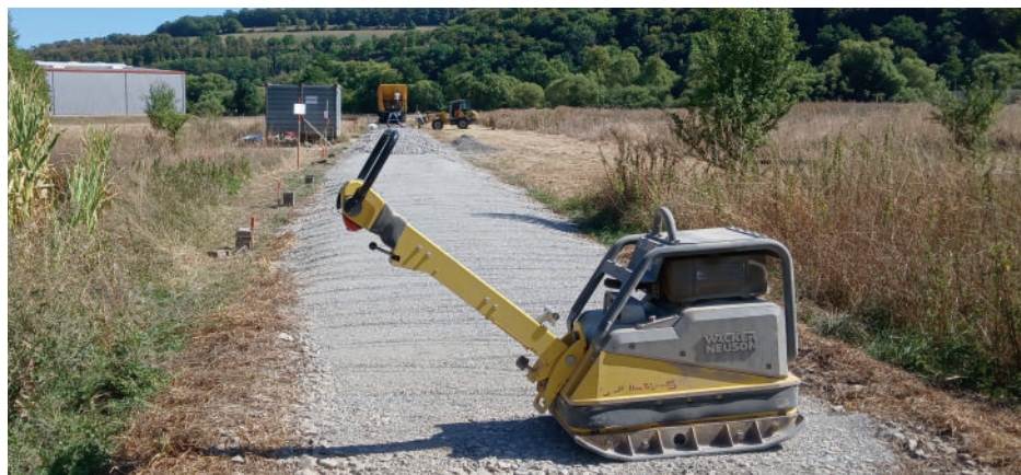
▲ Das Planum ist fertiggestellt. Bild: Ron Scherhauffer.
